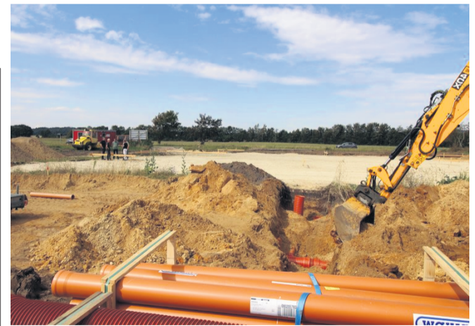
Byggeriet ventes at være afsluttet inden udgangen af året. Foto: Jørgen Ingvarsdén
